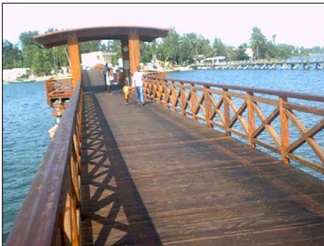
Photo 12 –Passerelles de Fadiouth - les deux passerelles sont visibles sur cette vue, novembre 2004 Thiam M.D.- 2006.
