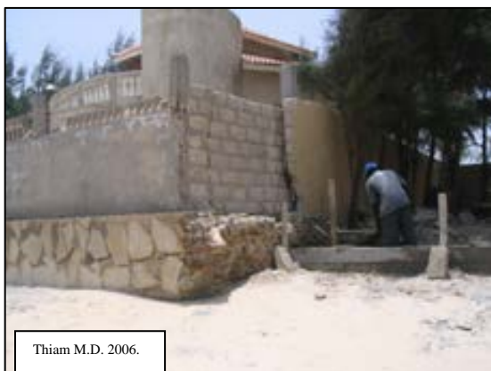
Photo 55' - Réfection d'un pan de mur emporté par la mer à Siendou
