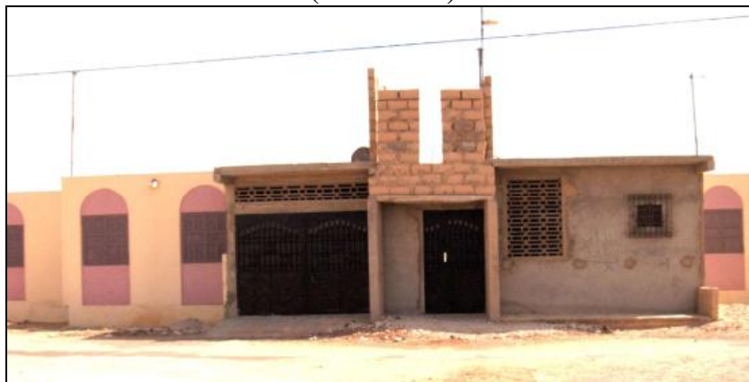
Photo 49 : L'appropriation résidentielle d'un habitat standardisé à la Cité Air France (Kounoune)
