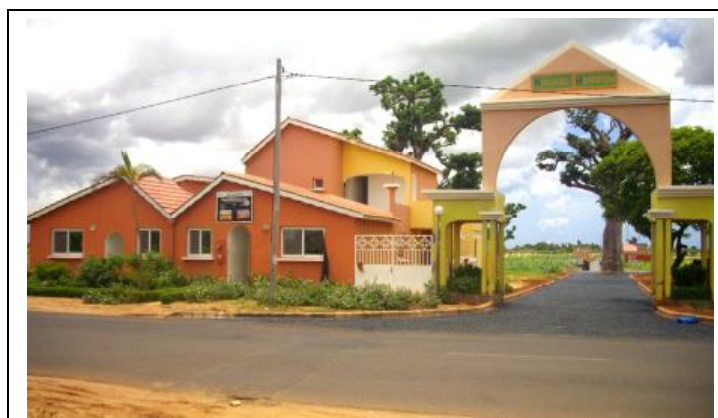
La villa témoin et la voie principale d'accès en cours de réalisation
