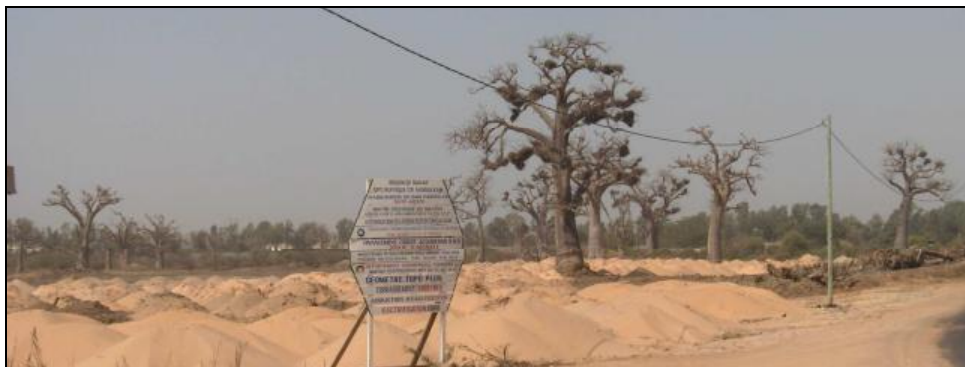
L'apport du sable dior pour le nivellement
