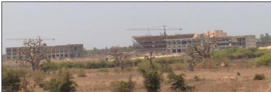
Photo 31 : Les travaux de construction de l'Université du Futur Africain
