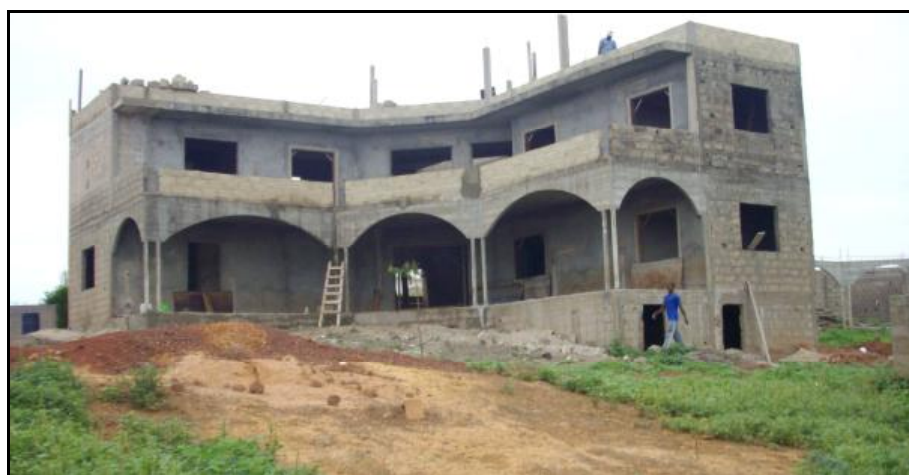
Une résidence en construction orientée vers le littoral
