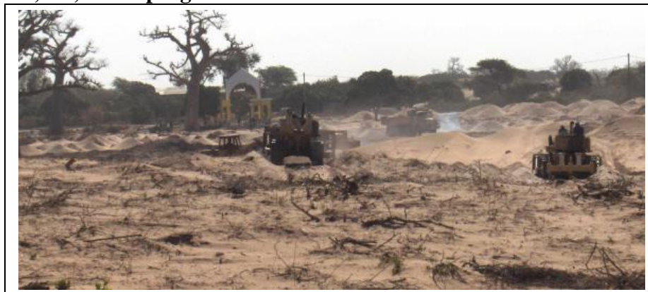
Les travaux de terrassement en 2007
