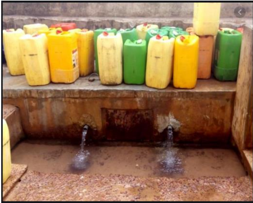
Figure 8 : Source aménagée de Gbokora
