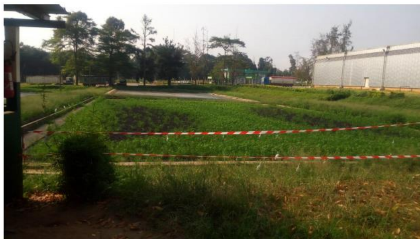
Photo 2 : Bassins de stockage anaérobie recouverts de végétaux
