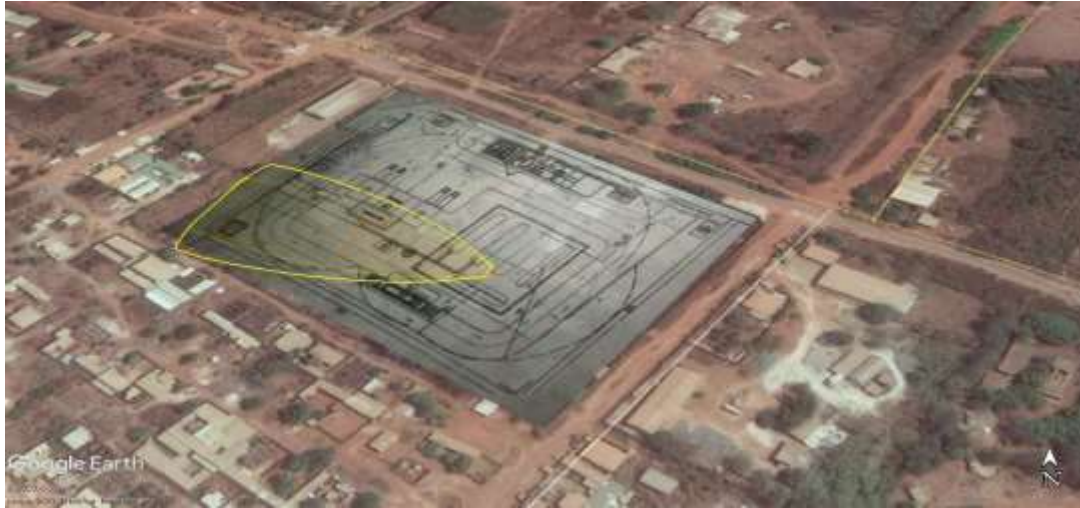
Figure 14 : Cartographie de l’UVCE de canalisation du centre emplisseur GPL de la société STAR OIL à Daloa
