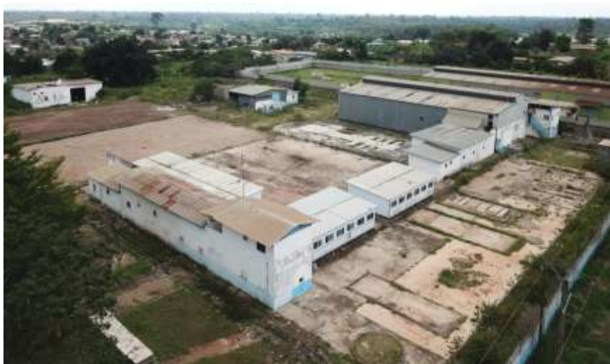
Figure 3 : Localisation du centre emplisseur de gaz GPL de la société STAR OIL à Daloa
