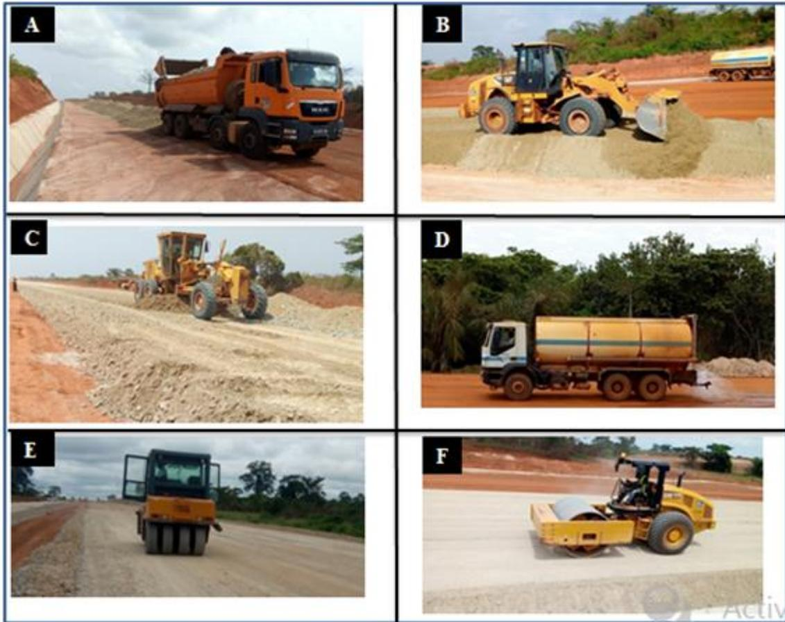
*A) Camion benne ; B) Bulldozer ; C) Niveleuse ; D) Camion-citerne; E) Compacteur pneumatique P4 ; F) Compacteur vibrant*
