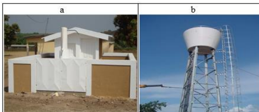
Figure 7 : Système d'hydraulique Villageoise améliorée Borne fontaine ; (b) Château en polyester
