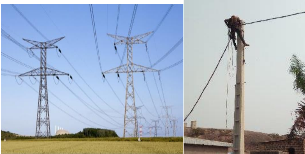
Figure 1 : Ligne de transport et distribution haut tension
