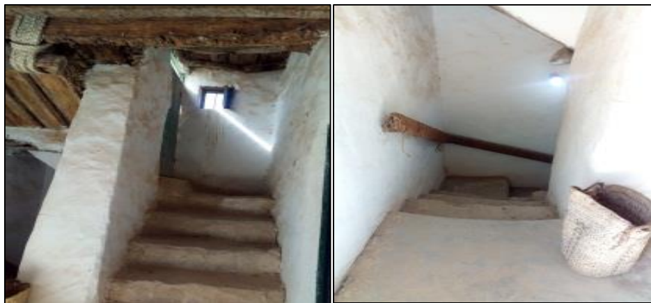
Figure 166 L'escalier menant au second étage de la maison Siwie de l'intérieur. Photos prises par la chercheuse.
