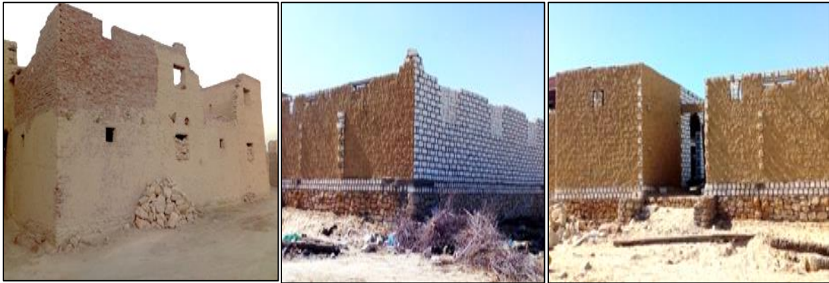
Figure 181 Revêtement des nouvelles constructions en Karchife. Photos prises par la chercheuse.
