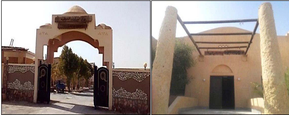
Figure 311 Centre des Industries Artisanales de Siwa. Photos prises par la chercheuse.
