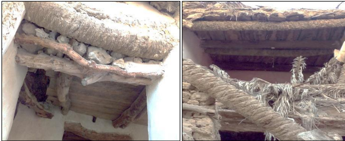
Figure 176 Le toit (Sakifa) des maisons. Photos prises par la chercheuse.
