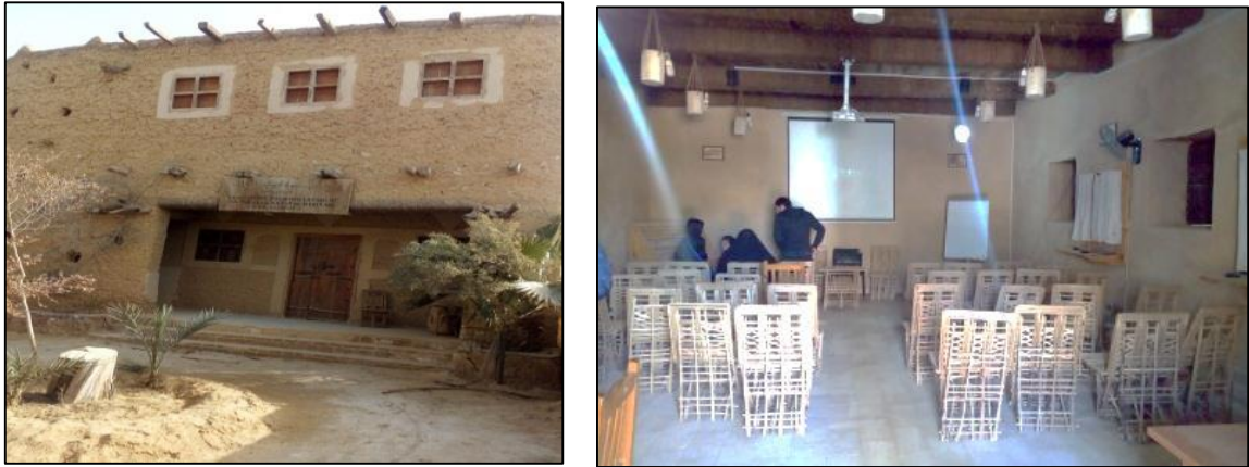
Figure 297 Le Centre Nationale de documentation du patrimoine de Siwa de l'extérieur et sa salle de projection Photos prises par la chercheuse.
