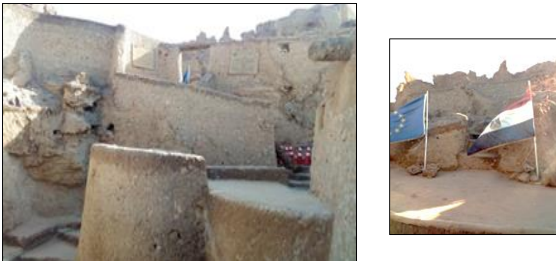
Figure 304 Chantier de restauration de Siwa-Chali. Photos prises par la chercheuse.
