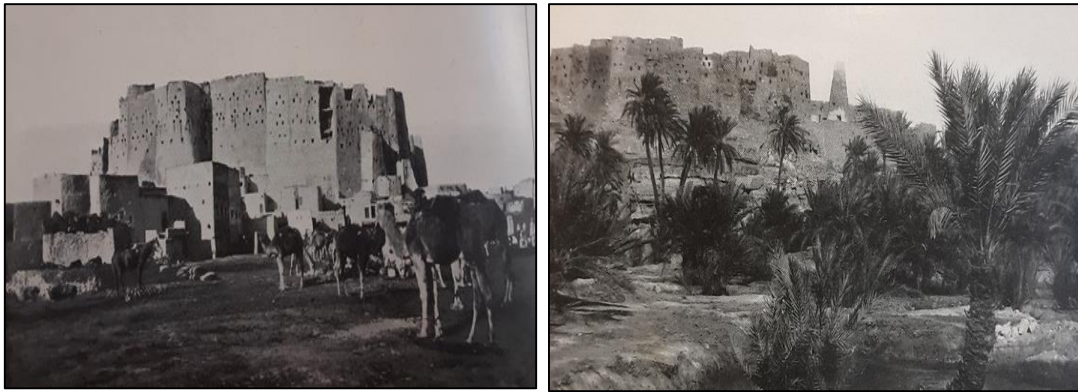
Figure 93 Siwa Chali et Siwa Aghormi en 1904. Source : (Steindorff , 1904).
