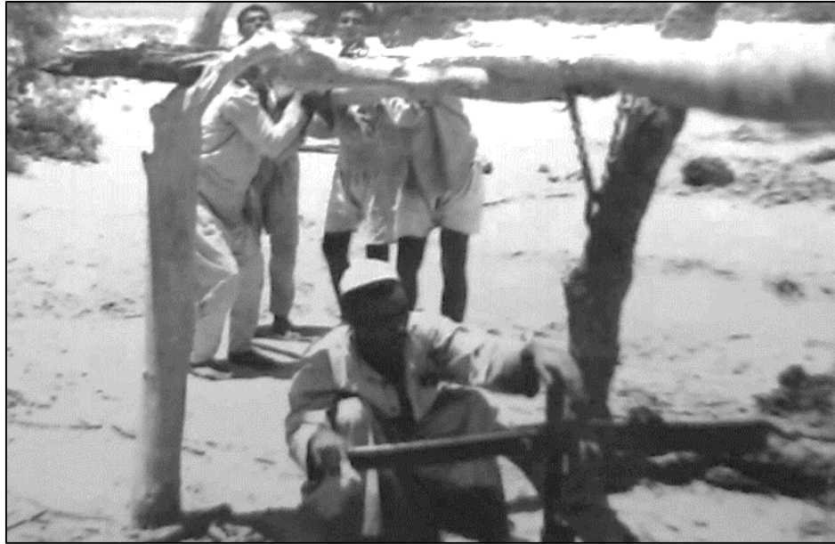
Figure 70 Creusage des puits de Siwa à la traditionnelle. Source : (1980, القلاوي).
