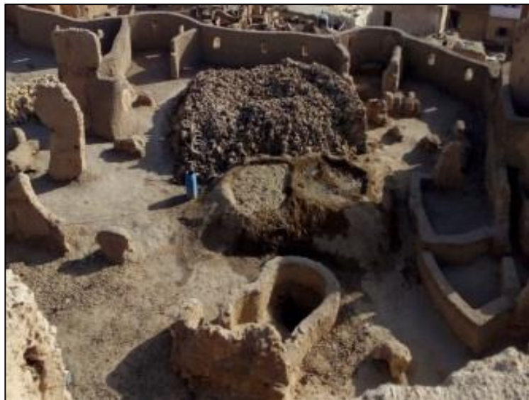
Figure 305 Travaux de restauration à l'Ancienne Chali. Photos prises par la chercheuse.
