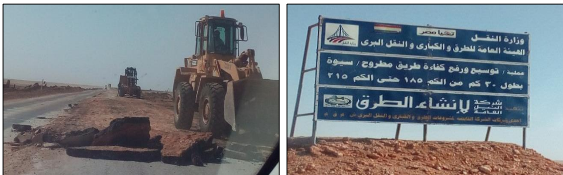
Figure 326 Travaux d'expansion et d'augmentation de l'efficacité de la route Siwa-Matrouh. Photos prises par la chercheuse.
