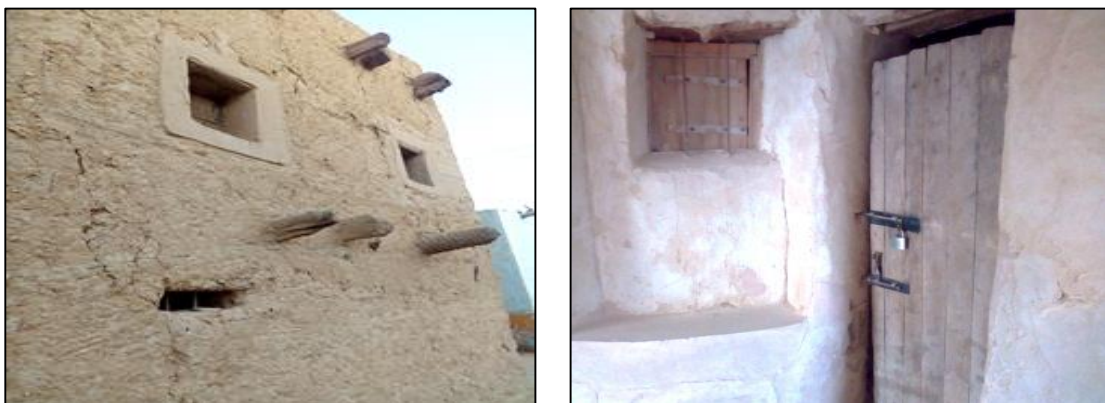
Figure 175 Les fenêtres (Allumen) et les portes. Photos prises par la chercheuse.
