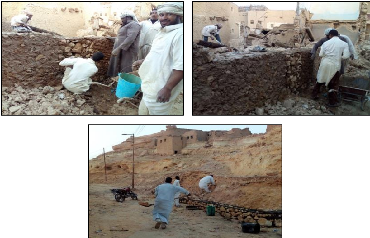
Figure 173 Les maîtres-maçons de Siwa. Photos prises par la chercheuse.
