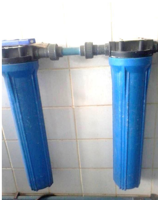
Photo 7 : Filtre à 10 \mu de la station de traitement de l'eau pour hémodialyse CHUY (GUEGUIM, 2015).
