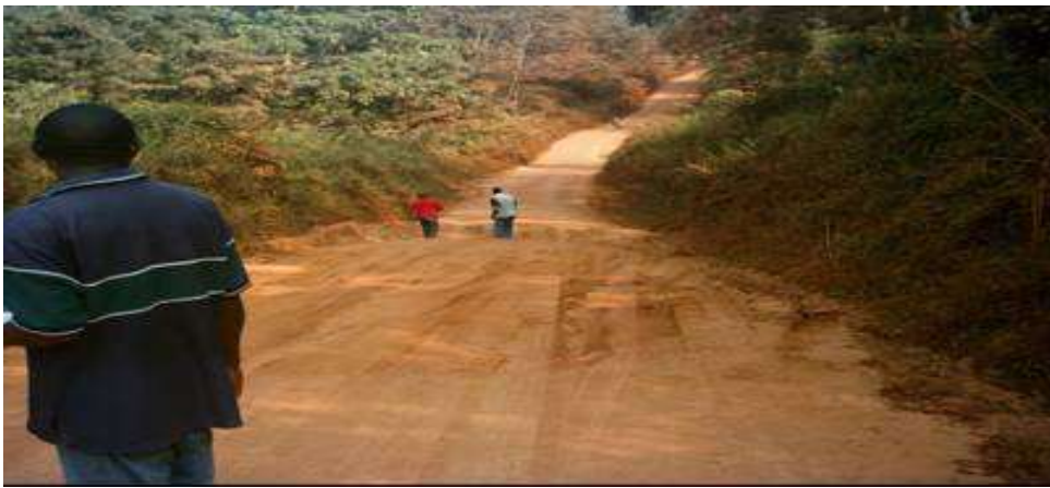
Figure 102 : Bourbier de plus de 50 cm de profondeur créé par les grumiers au PK 30 + 000 de la route Yokadouma-Bangoué en 2006
