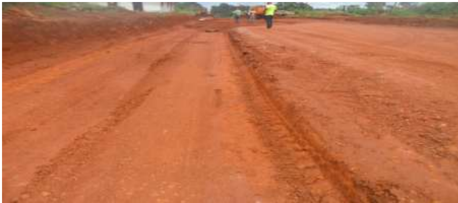
Figure 94 : Grave latéritique en couche de forme au PK 0+050 route Mbama-Messamena 2017
