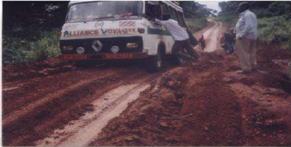
Figure 101 : Bourbier créé par les gros porteurs au PK 2+000 du tronçon Ngoura – Yola après violation de la barrière de pluies en septembre 2007
