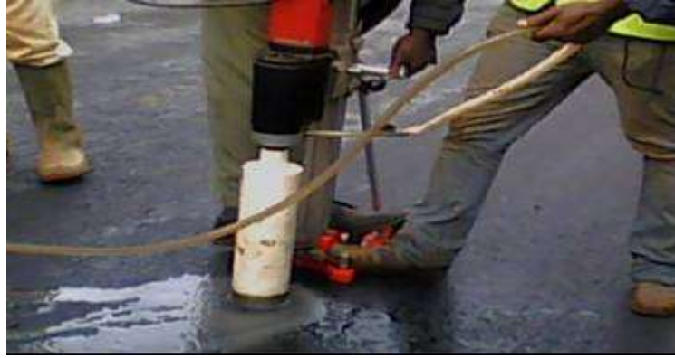
Figure 23 : Carottage sur la couche de roulement au PK 45+480D, route : Abong-Mbang-Bonis
