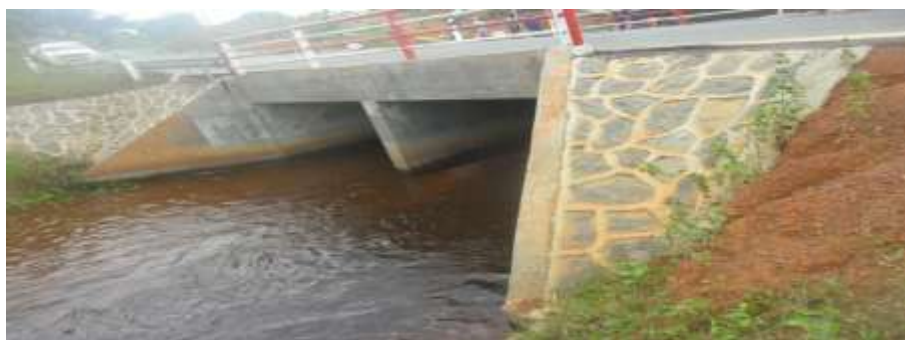
Figure 61. Construction d'un dalot double au PK 45 de la route Abong-Mbang - Bonis en 2009
