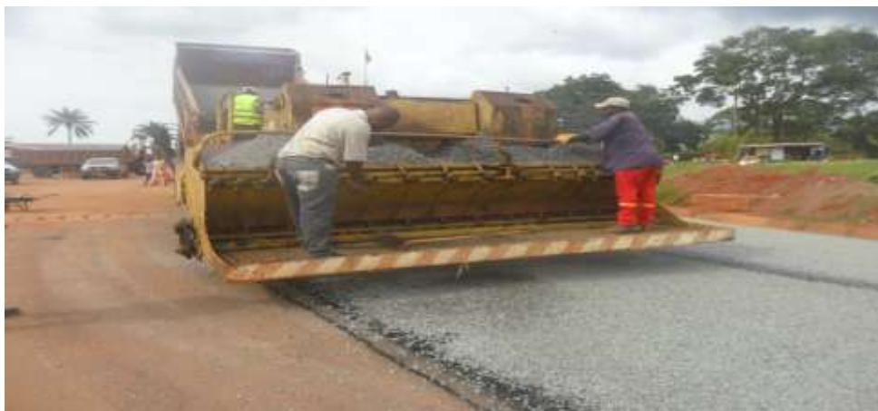
Figure 60. Mise en oeuvre des enduits superficiels bicouche 6/10 et 10/14 au PK 0+040 voie n°10 voirie d'Abong-Mbang en 2017
