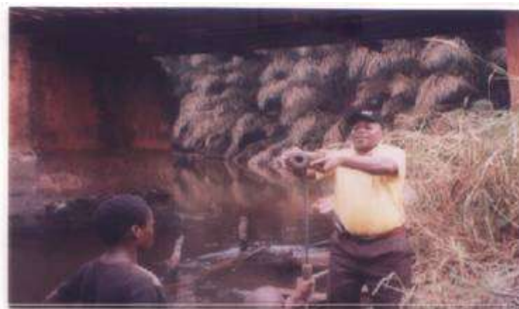
Figure 29 : Sondage au pénétromètre dynamique au PK 19+900 du tronçon Ampel – Lomié au niveau de la rivière Dja (village Djaposter)
