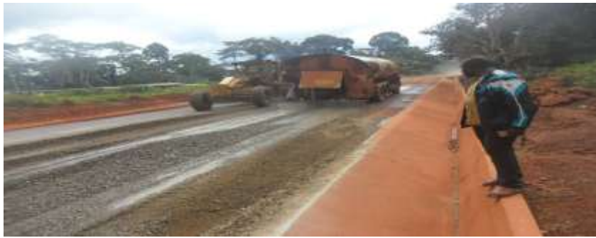
Figure 58: Mise en oeuvre de la couche de base en 0/31.5 au PK 0+00 de la route Mbama-Messamena en 2017
