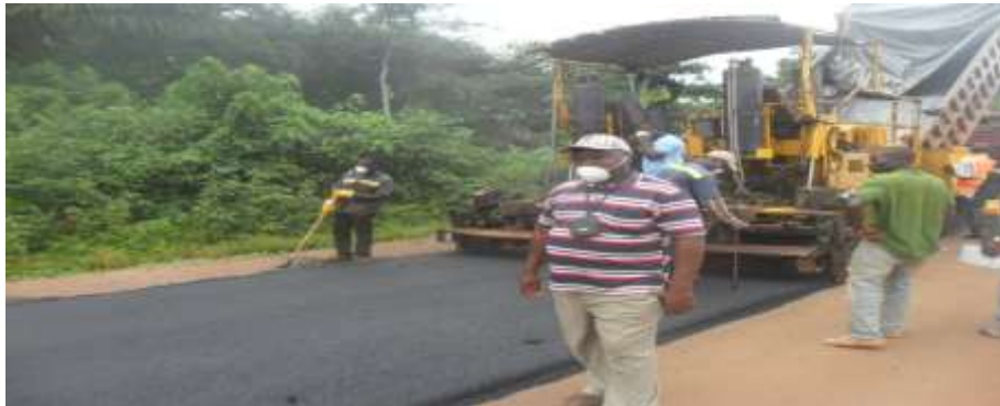
Figure 59. Mise en oeuvre de la couche de roulement en béton bitumineux 0/10 au PK 4+100 de la route Mbama-Messamena en 2017
