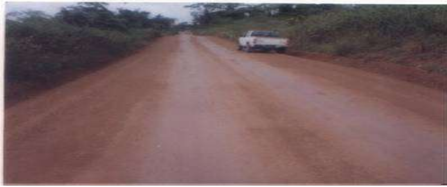
Figure 93 : Grave latéritique en couche de roulement PK 8 + 500 de la route Mandjou-Batouri en 2006
