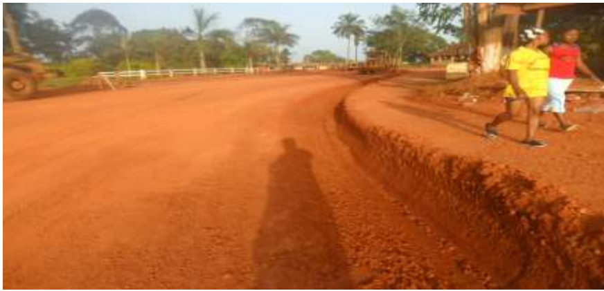
Figure 97. Grave latéritique en couche de fondation PK 3+000 route Mbama-Messamena en 2016
