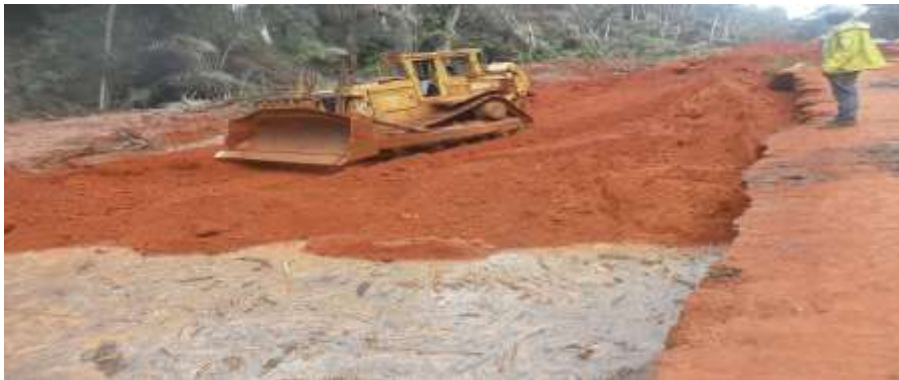
Figure 95. Grave latéritique en remblais dans les zones de purge PK 1+800 de la route Mbama-Messamena en 2017
