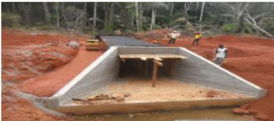
Figure 96. Grave latéritique en bloc technique du dalot simple au PK 1+850 (route Mbama-Messamena) en 2017
