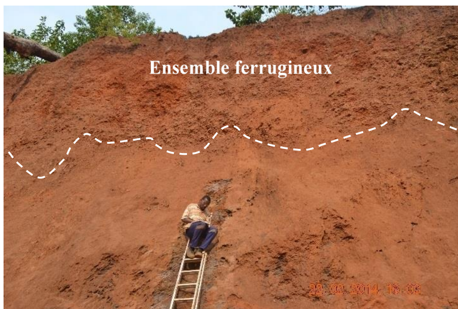
Figure 48 : Vue de l'ensemble ferrugineux dans le profil.
