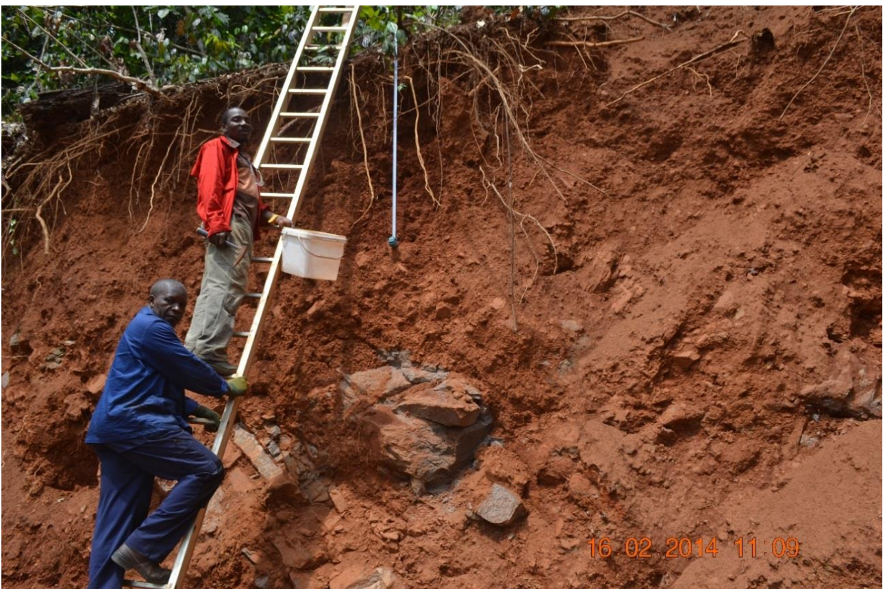
Figure 28 : Observation in situ d'un talus à Nkout.
