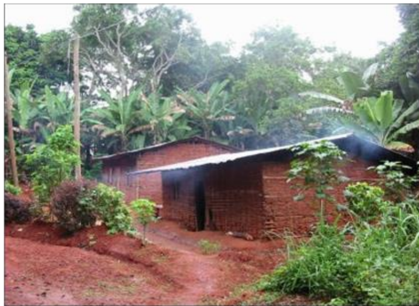
Figure 1.5: Maison en terre avec ossature en bois des régions forestières du Cameroun.
