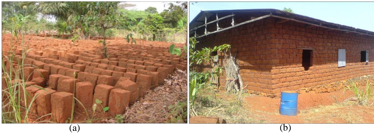
Figure 1.7: Briques de terre crue en phase de séchage (a) et maison en brique de terre crue ou adobe (b).
