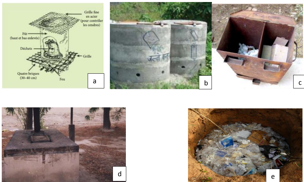
Fig.2. Type d'incinérateur artisanal (a-Incinérateur à fût ;b- Incinérateur à Santapur ;c- Incinérateur à Manahari, d-Incinérateur artisanal MONFORT, e-Incinérateur à fosse).
