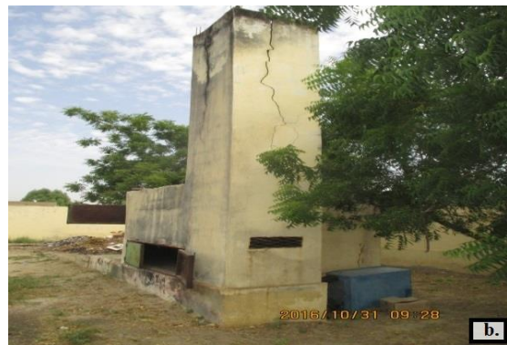
Fig.28. Incinérateur à une chambre de combustion de type Montfort (a : déchets mis dans l'incinérateur ; b : vue d'ensemble de l'incinérateur).
