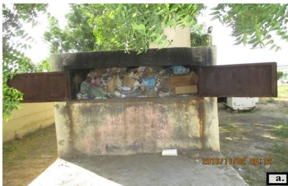
Fig.28. Incinérateur à une chambre de combustion de type Montfort (a : déchets mis dans l'incinérateur ; b : vue d'ensemble de l'incinérateur).
