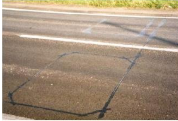
Figure 11 : Boucle électromagnétique ([20])
