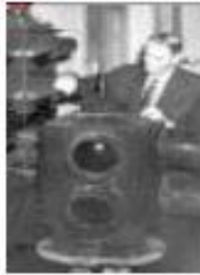
Figure 1 : premier feu bicolore électrique de l'histoire à Salt Lake City ([4])
