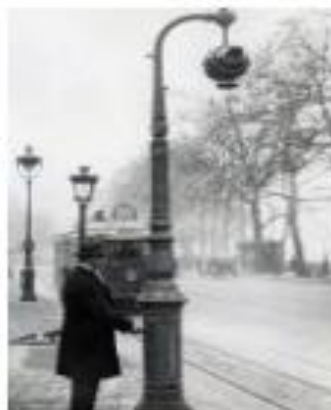
Figure 4 : Commande manuelle pour piétons pont des arts, 1930([4])
