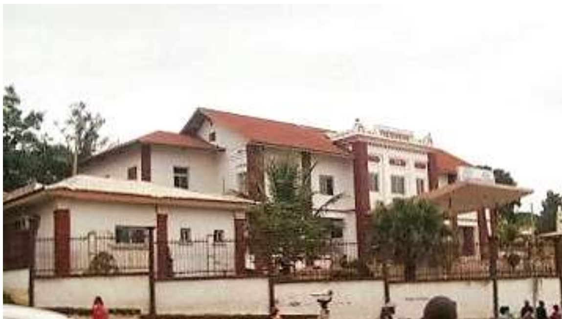
Image n°1 : Ancien bâtiment du FEICOM
