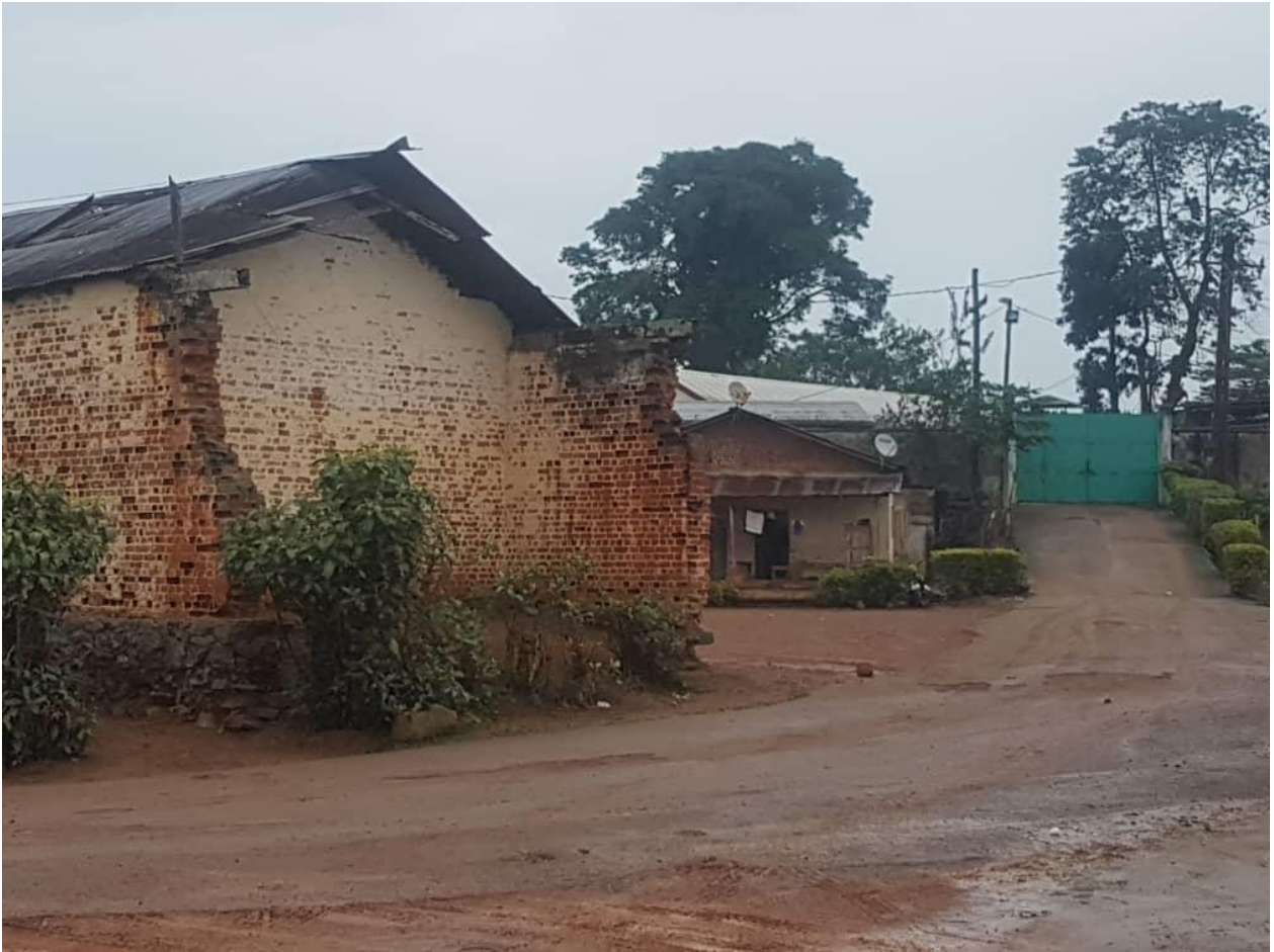
Figure 3.3: Campement du personnel pénitentier de la Prison Centrale d’Ebolowa
