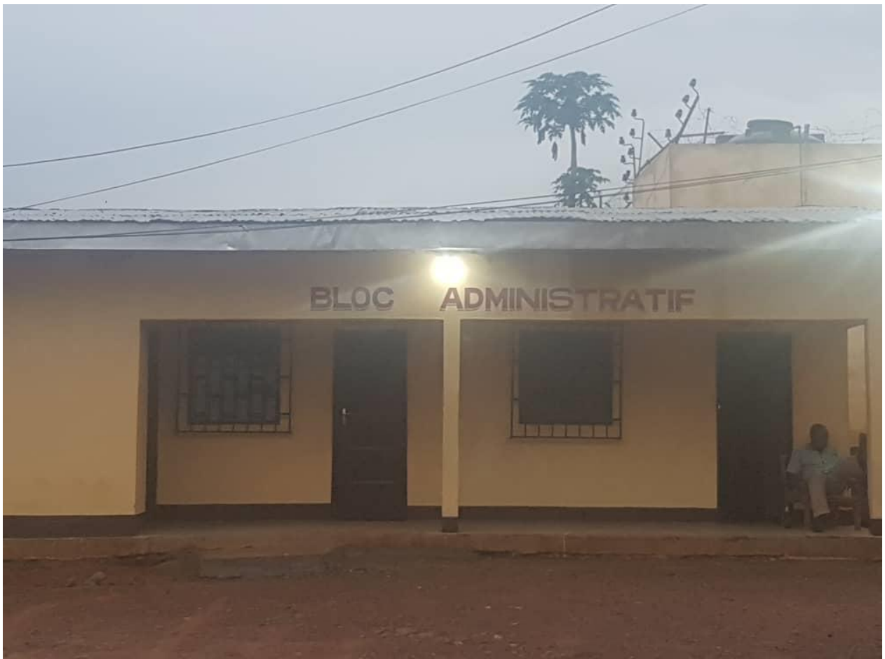
Figure 3.4 : Bloc Administratif de la PCE
