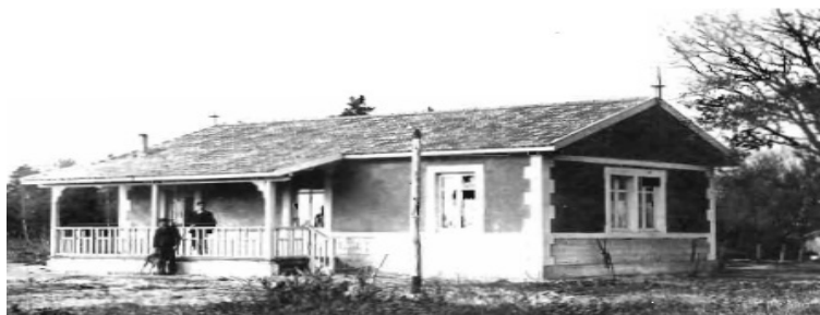
Figure 30 : Couverture de tuiles sur bâtisse coloniale
