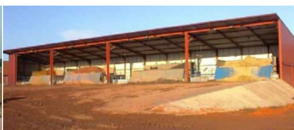
Figure 6 : Stockage des terres
