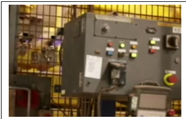
Figure II.6 : centrale de commande des robots
