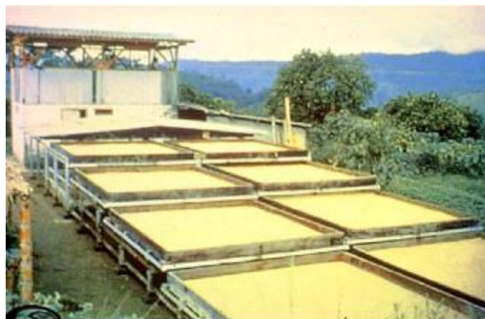
Figure I-8: Bacs de lavage (pour la fermentation des graines)
