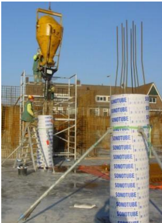
Figure 5: coffrage en carton de poteau en béton [5]
