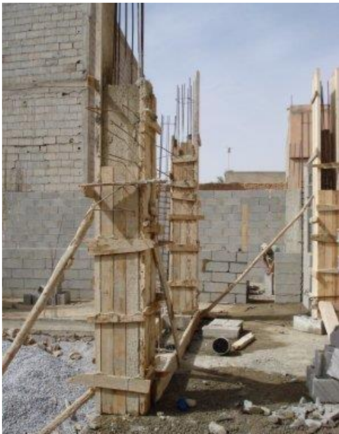
Figure 9: coffrage en bois
