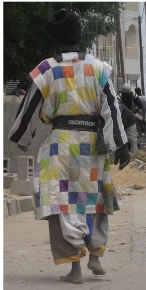
Baay fall en activité pour la réparation du mur de clôture de leur guide, Serigne Cheikh Ndigueul Fall
