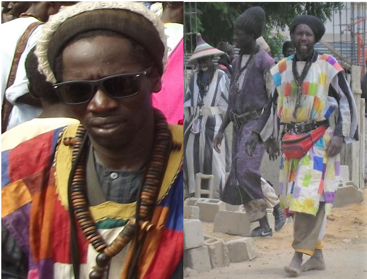
Baay fall en activité pour la réparation du mur de clôture de la maison de leur marabout Sérigne Cheikh Ndigueul Fall à Touba (Source Ibrahima DIOUME)
