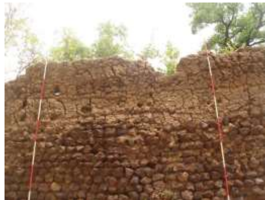
Figure 3 : Partie centrale du rempart Ouest et Détail des emplacements supposés de poutres
