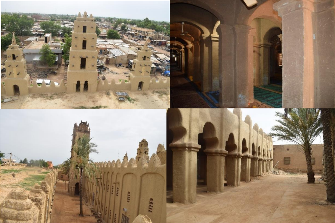
Figure 29 : Intérieur de la mosquée de NIONO Source : © nous-mêmes, Auteur : Sory Ibrahim CAMARA
