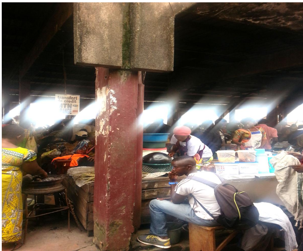
Photo 3: Petite restauration située dans le hangar n° 3
