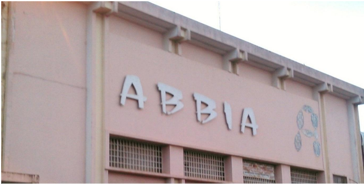
Photo 6: Façade extérieure du cinéma Abbia
