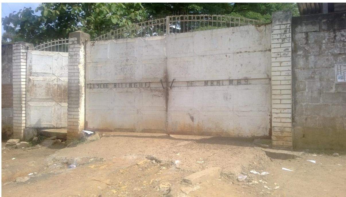
Photo 1: Entrée principale du Lycée Bilingue de Mbalmayo
