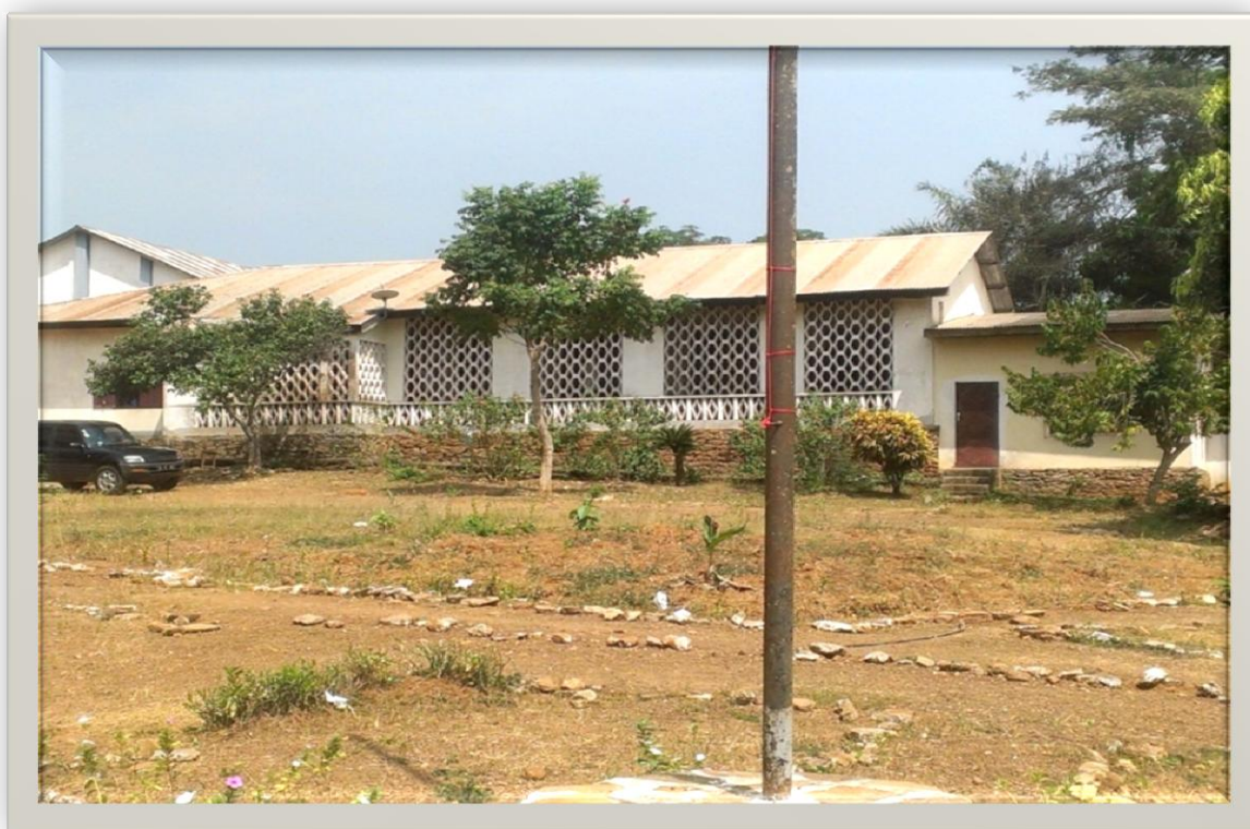
Photo 5 : Le bloc administratif du collège
