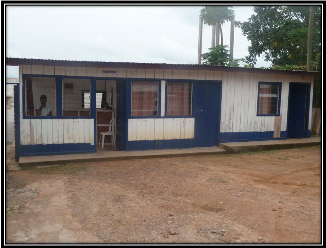
Photo 15 : direction et le service de réception d'un hôtel 1étoile
