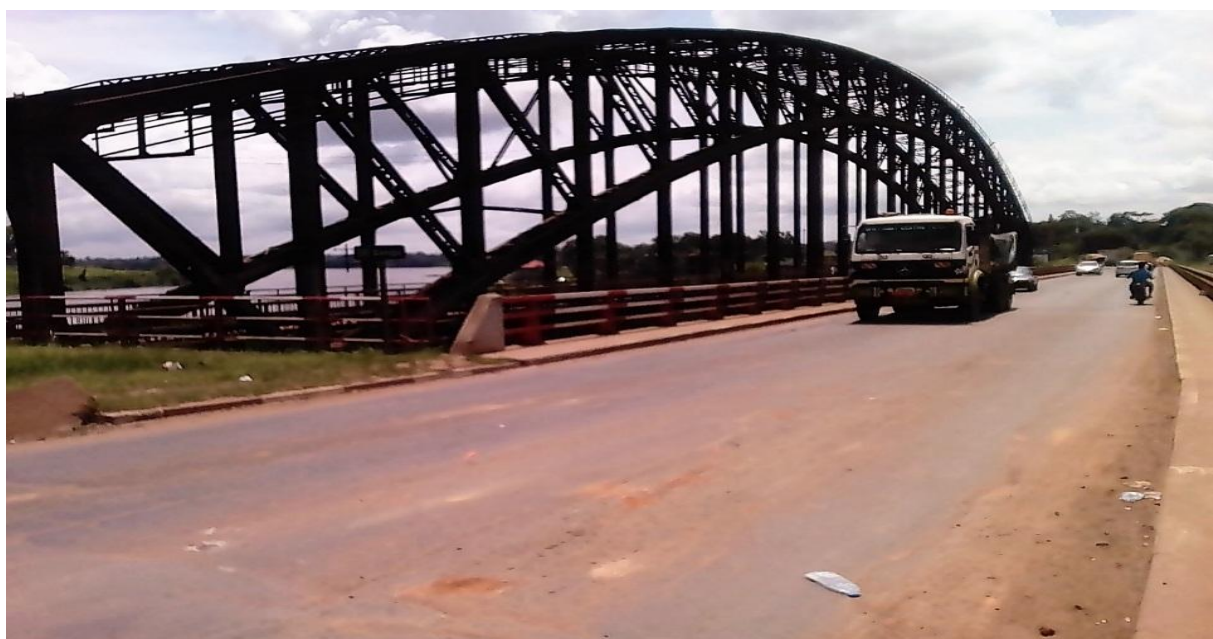
Photo 1: Le pont sur la Sanaga
