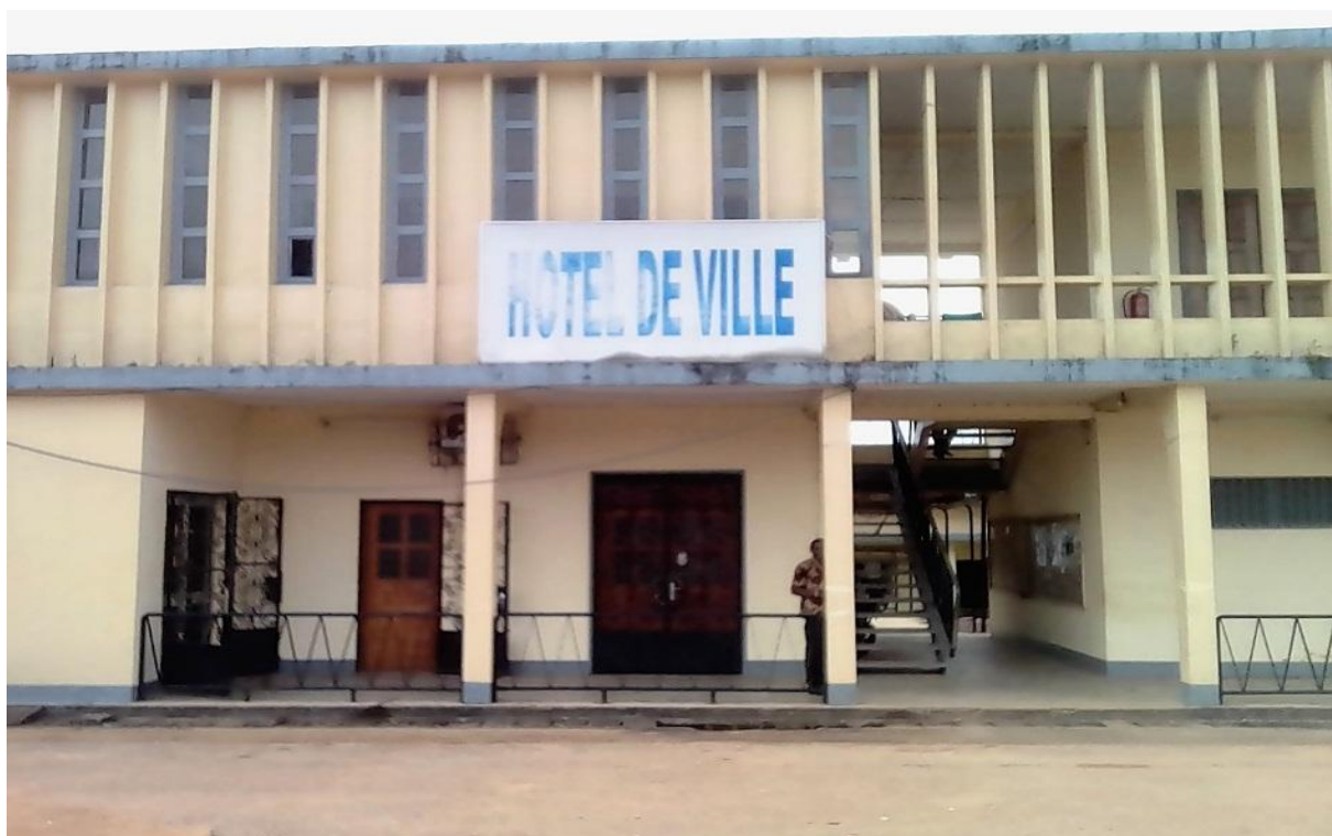
Photo 7 : La Communauté Urbaine d'Edéa (vue avant)
