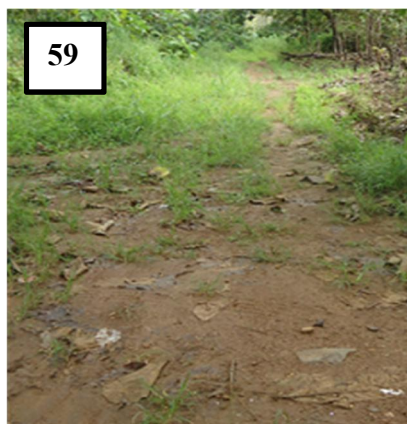
Photo59 : Piste d'accès envahie par les herbes
