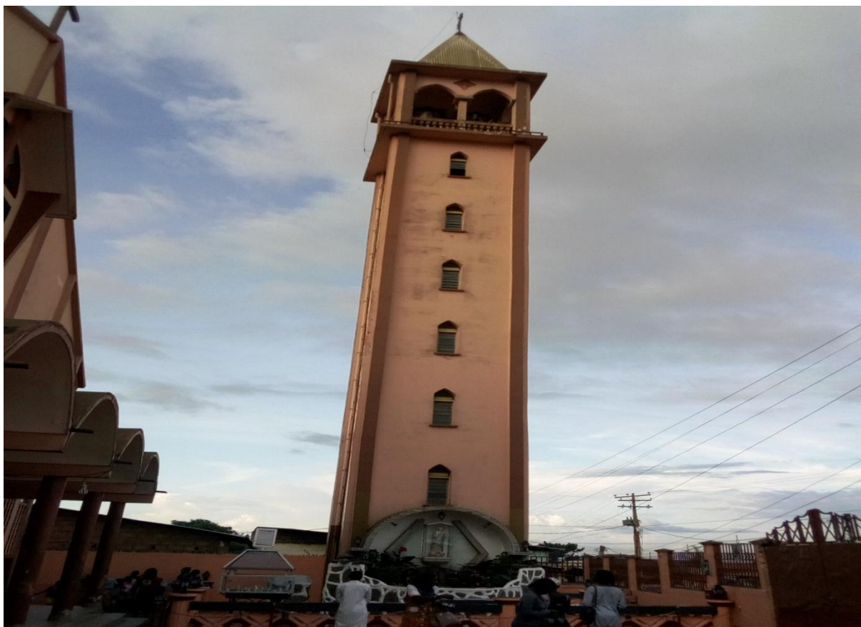
Photo 9: édifice abritant le clocher
