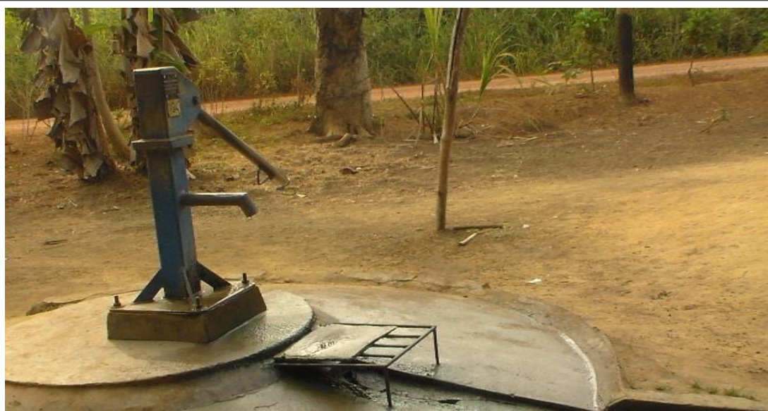
Photo 40: pompe du village d'Oveng vue de profil
