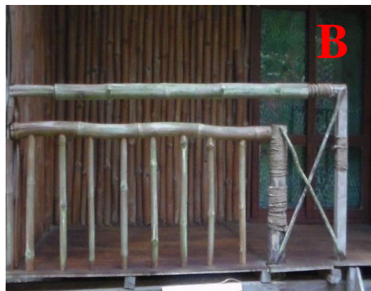
Photo 14: Véranda d'un bungalow vue de face
