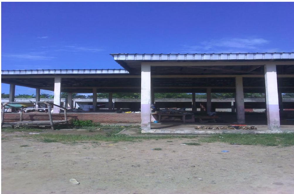
Photo 9 : Hangars construits au marché d'Ebebda par la commune
