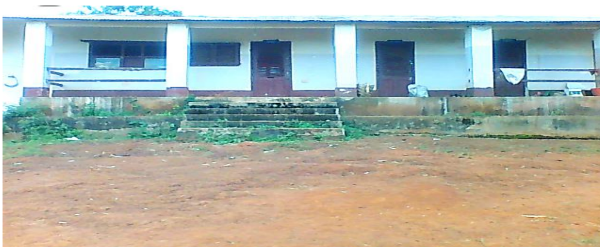
Photo N°5 : Les bureaux de la Direction Générale.
