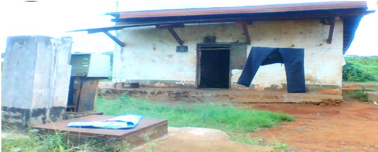
Photo N°2 : L'une des stations-services de la CFSO.
