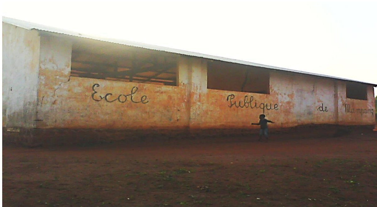
Photo N°8 : L'un des bâtiments de l'Ecole Publique de Mampang.
