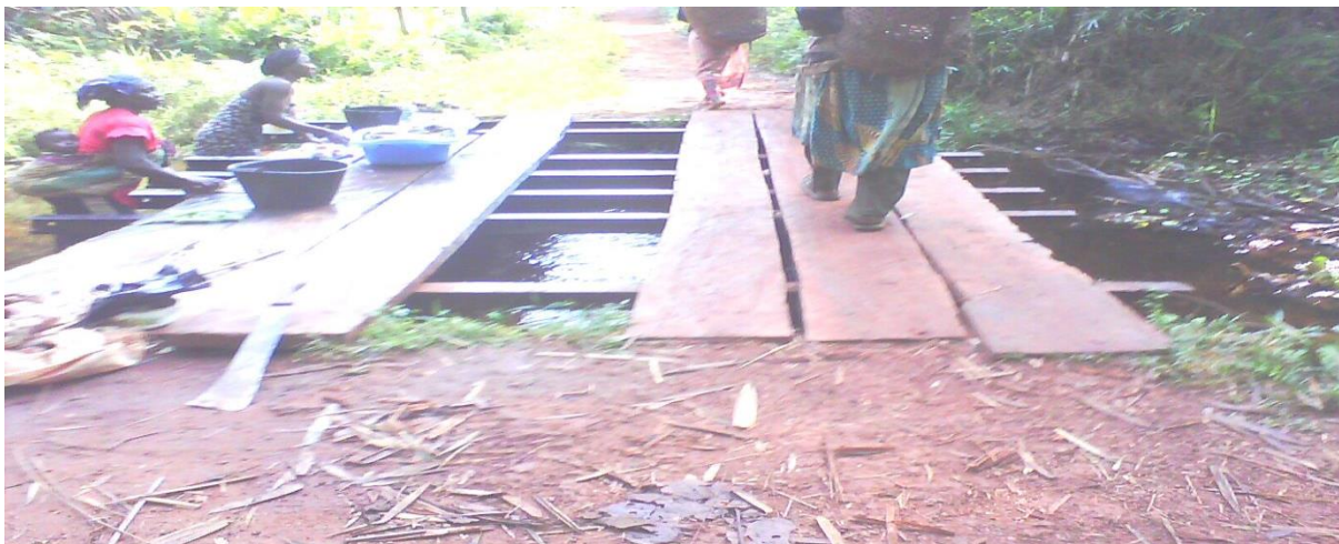
Photo N°3 : Pont en dur de la CFSO sur une digue.
