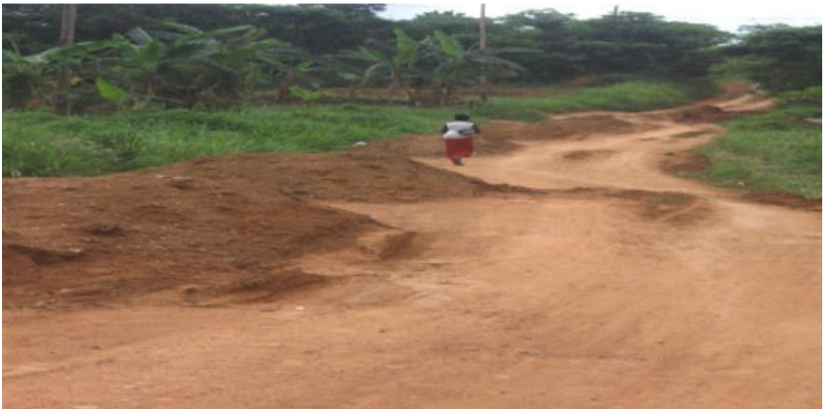
Photo 25: Dépôt de latérite par un particulier pour faciliter la circulation des grumiers.
