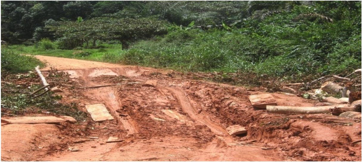
Photo 25: Dépôt de latérite par un particulier pour faciliter la circulation des grumiers.
