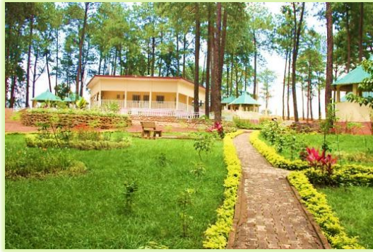
Photo a : les constructions de boukarous et d'un restaurant achevées au bois de Mardock.
