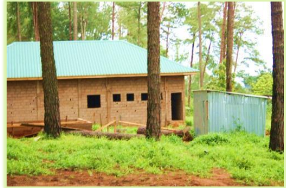
Photo b : les constructions du Motel en cours au bois de Mardock.
