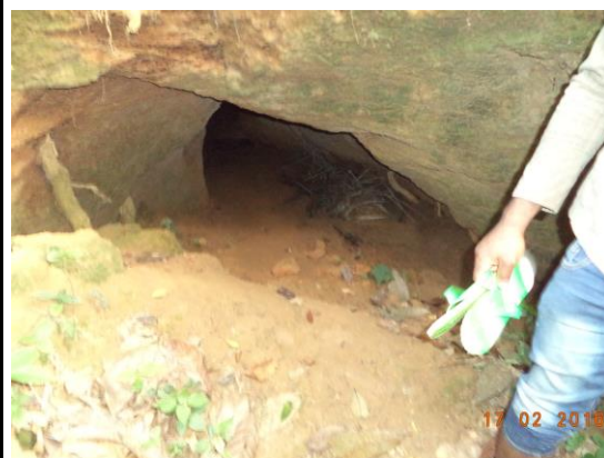
Photo 39 : Sortie brusque du tunnel souterrain menacé par les phénomènes d'érosion.
