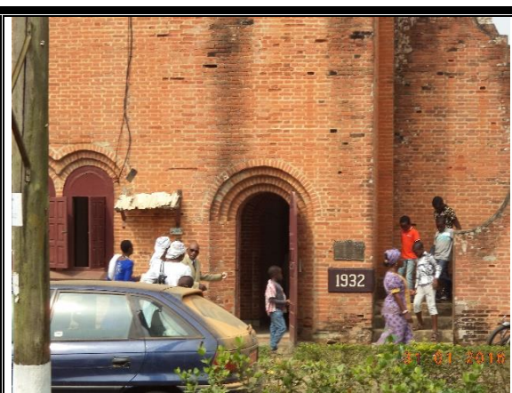
Photo 12 : Inscription de l'année d'implantation : Sur cette photo on peut lire à droite, la date de construction du temple.
