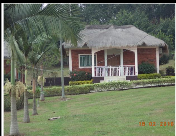
Photo 31: Logis en matériaux locaux
