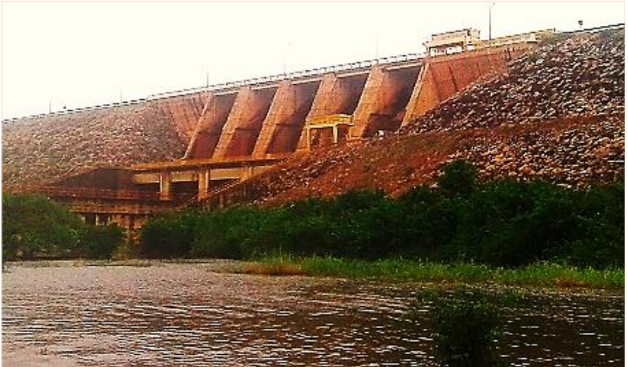
Figure 3 : Vue partielle du barrage hydroélectrique de Buyo (Côte d'Ivoire). (Auteur N'dri O.R., 2020)
