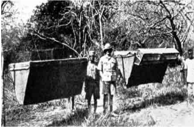
Figure 7 : Deux modèles de piège à vecteurs conçus pour les glossines : piège de Harris à gauche et piège biconique à droite (sleeping-sickness.ird.fr), consulté le 9 avril 2014.
