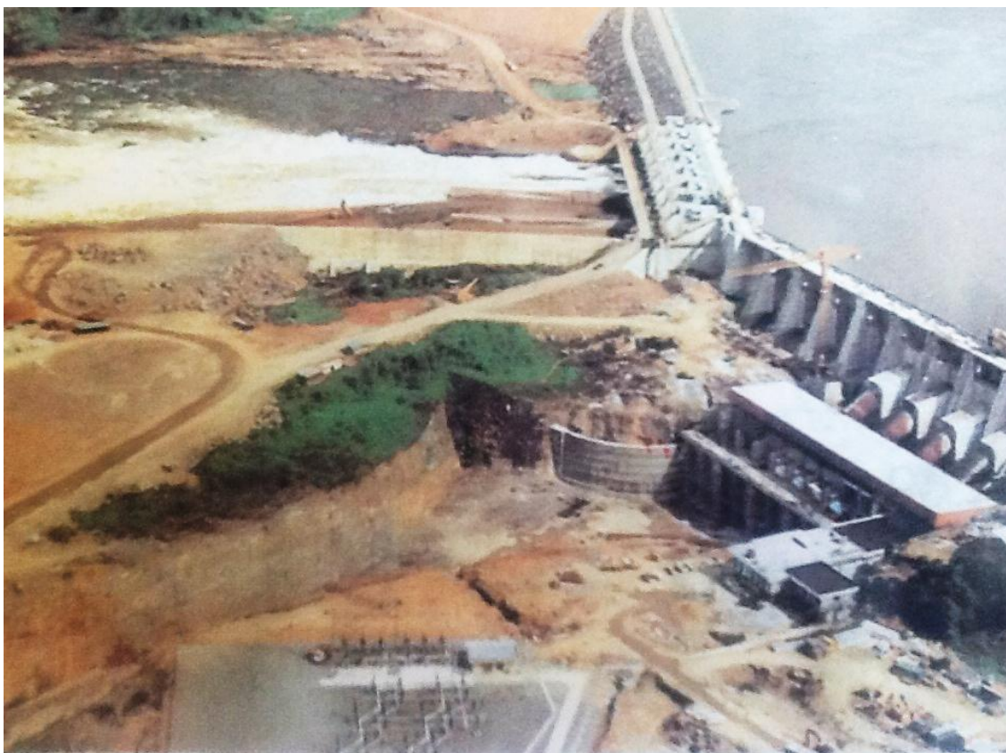
Photo 5: le barrage hydroélectrique de Songloulou en chantier.
