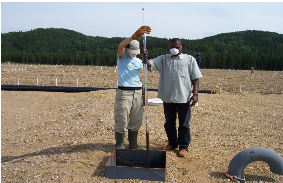
Photo 3 : Mesure de la longueur des boues au fond d'une fosse septique (HQ)
