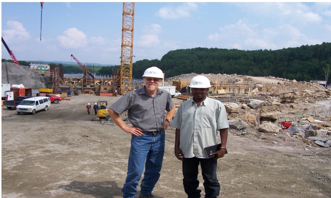
Photo 7 : Surveillance des travaux au niveau du chantier (HQ)
