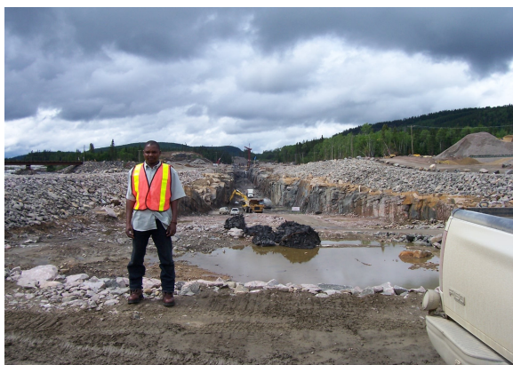
Photo 8 : Vérification au niveau d'un bassin de récupération des eaux usées du chantier (HQ)
