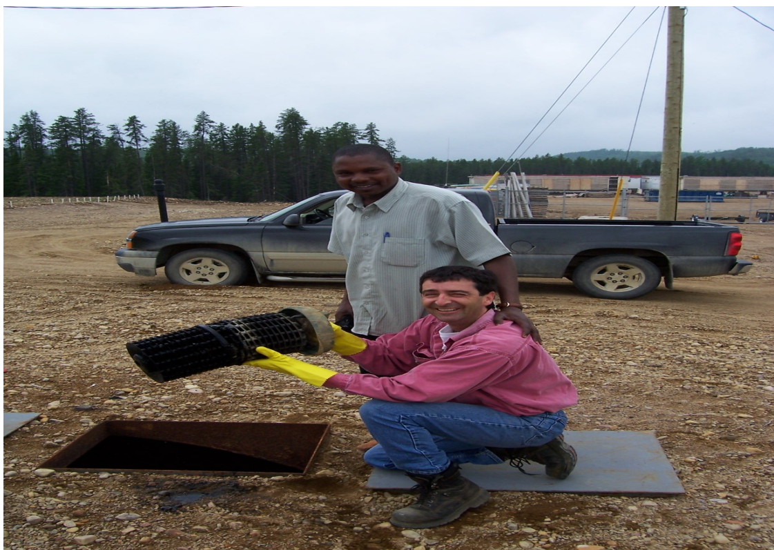
Photo 4 : Nettoyage des filtres d'une fosse septique (HQ)
