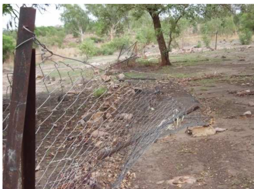
Photo 10 : Dispositif sécuritaire défaillant
