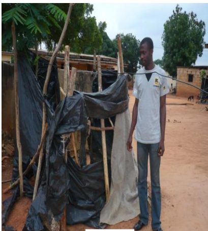
Photo 3 : Dégradation du périmètre de protection d'une latrine traditionnelle à Koubi
