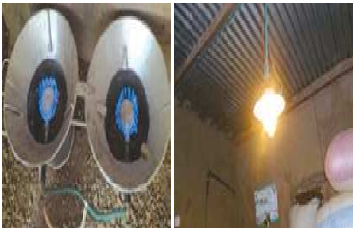
Figure 15 : utilisation du biogaz : foyer à biogaz (à gauche), lampe à biogaz (à droite)
