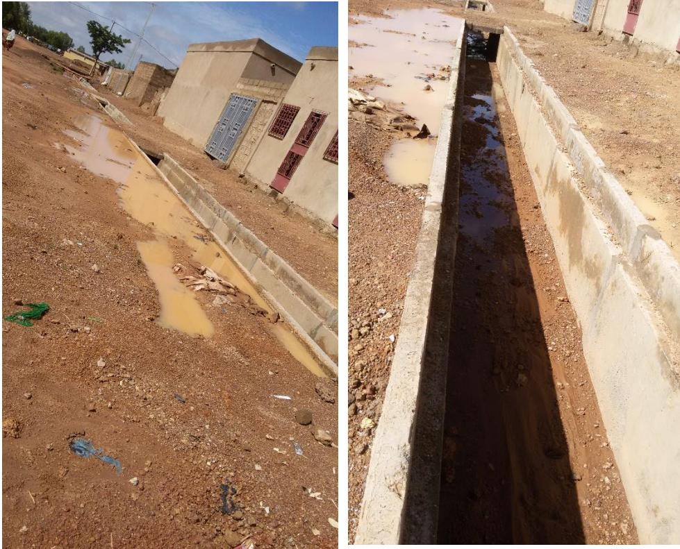
Figure 13 Collecteurs secondaires contenant de la terre au quartier Cissin.
