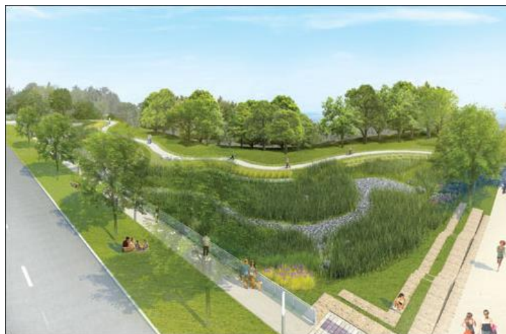
Figure 19 Image d'un bassin de retenue à ciel ouvert.
