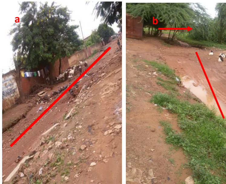
Figure 18 Photo illustrant un passage d'eau au quartier Dassasgho (a et b).
