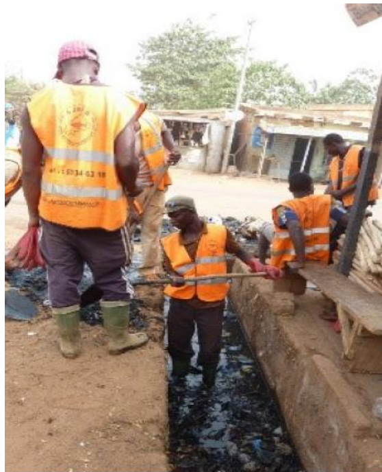
Figure 11 Photo du curage d'un collecteur primaire par les agents techniques de la mairie.
