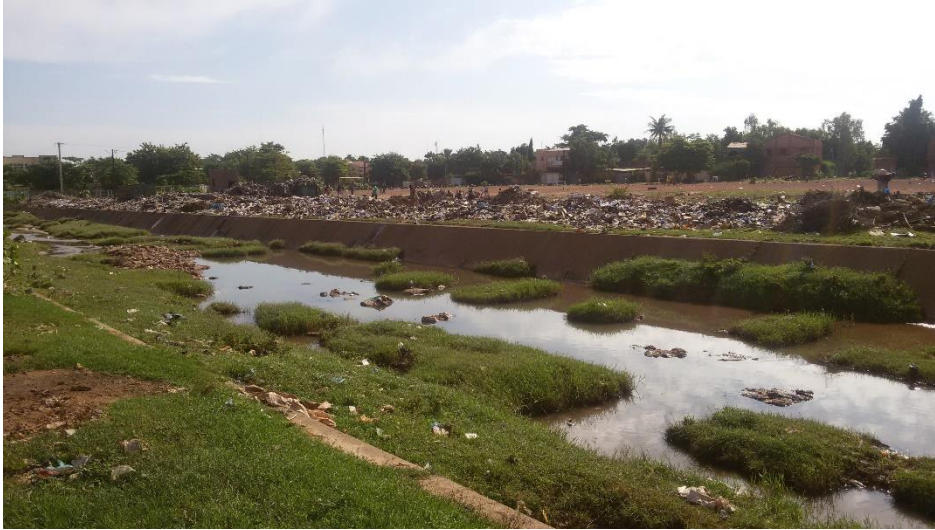
Figure 7 Photo du canal primaire du Mogho Naaba au quartier Cité An III. Source : Enquête de terrain, août 2018
