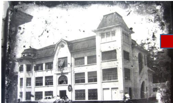
Immeuble John Holt en 1907.
