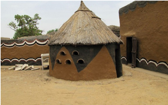
Figure 3 Cases rondes à toiture en chaume, la relation extérieur est assurée par des fenêtres circulaires en argile cuite, (photo H.Chezeville)
