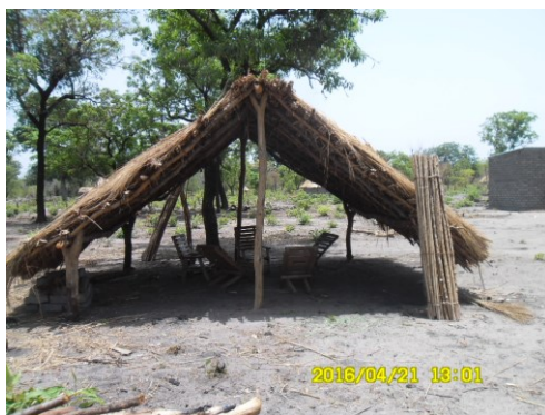
Figure 36 Un hangar à 2 pentes, dabalayé en arabe tchadien. (Photo Tamia 2014)
