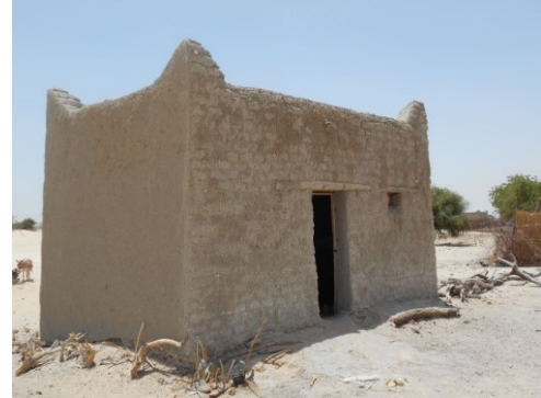
Figure 25 Unité d'habitation en construction, matériau terre est dominant. La présence des acrotères servant de brise vent, (photo Tamia 2018)
