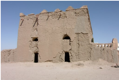
Figure 18 Façade latéral droite, la présence des égouts, acrotère et des murs son massif avec une épaisseur de 60 cm à 80 cm (photo Tamia 2014)
