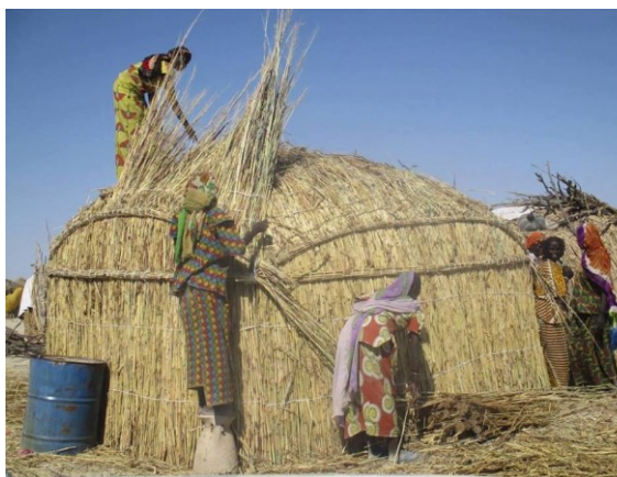
Figure 30 Les femmes de Bagasola au Tchad entraînent de construire leur Kouzi, culture constructive base sur l'entre aide permettant de construire très vite et partage le savoir-faire.(photo Tamia 2018)
