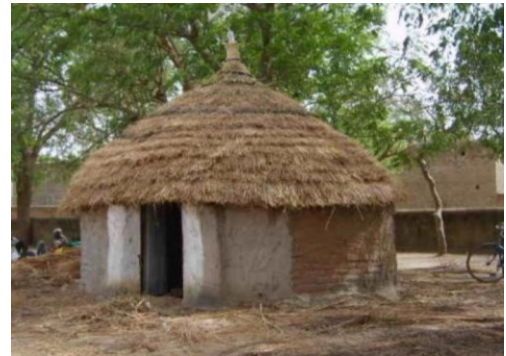
Figure 38 Case en construction, le mur en terre crue et toiture en chaume.(photo P. Apostolique de Mongo)
