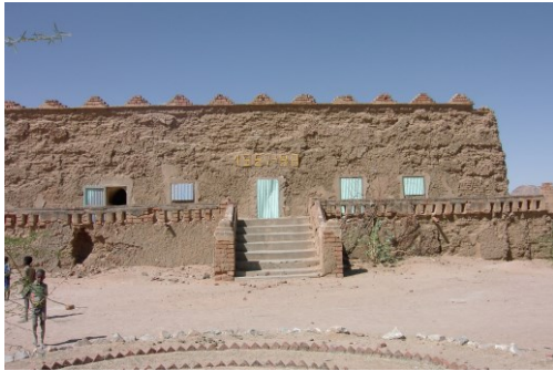
Figure 16 Façade principale de la première sous-préfecture de Biltine construit en terre crue, (photo Tamia 2014)
