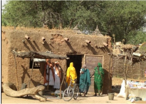
Figure 26 Une maison construite entièrement terre qui sert un lieu pour moudre le moulin communautaire. (photo ACRA-Tchad 2015)
