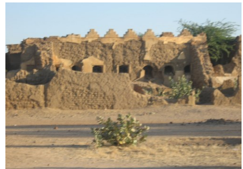
Figure 20 Maison Bartoli de la ville Biltine, une architecture coloniale en terre crue construite vers 1914-1928.
