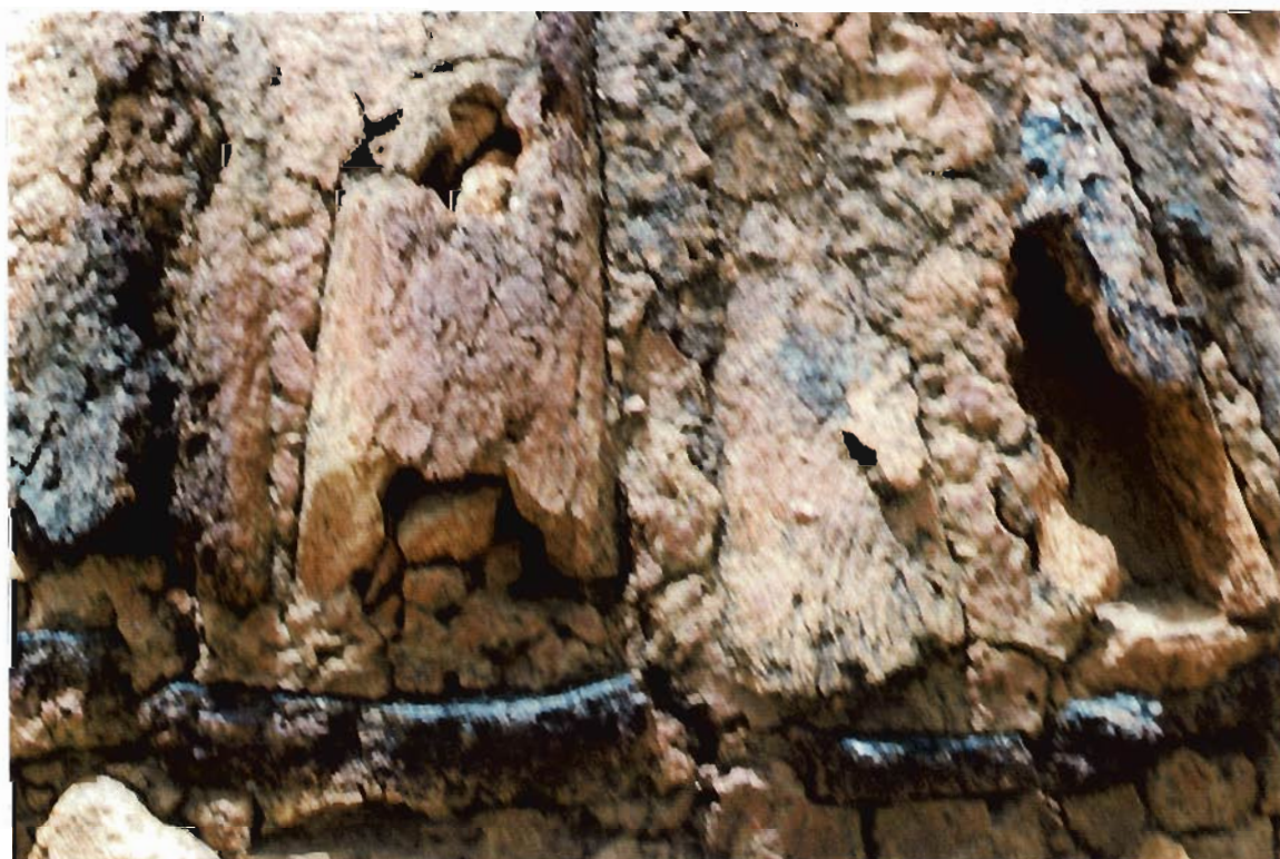
B - Détails de l'architecture : réemploi de tuyères . Photo Kiéthéga 84.
