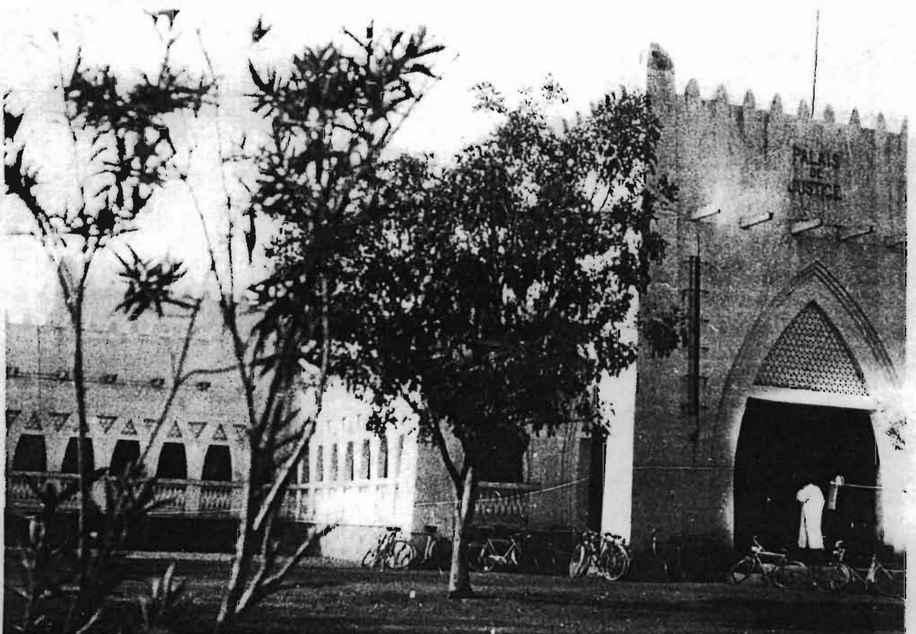
Bâtiment administratif : Palais de justice style néo-soudanais (photo ANSOM - France)
