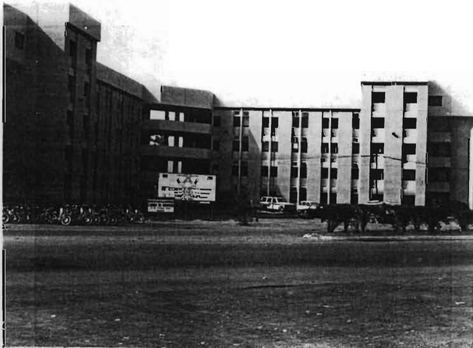
Bâtiment administratif : Immeuble de bureau (photo C. Sissao, 1991)
