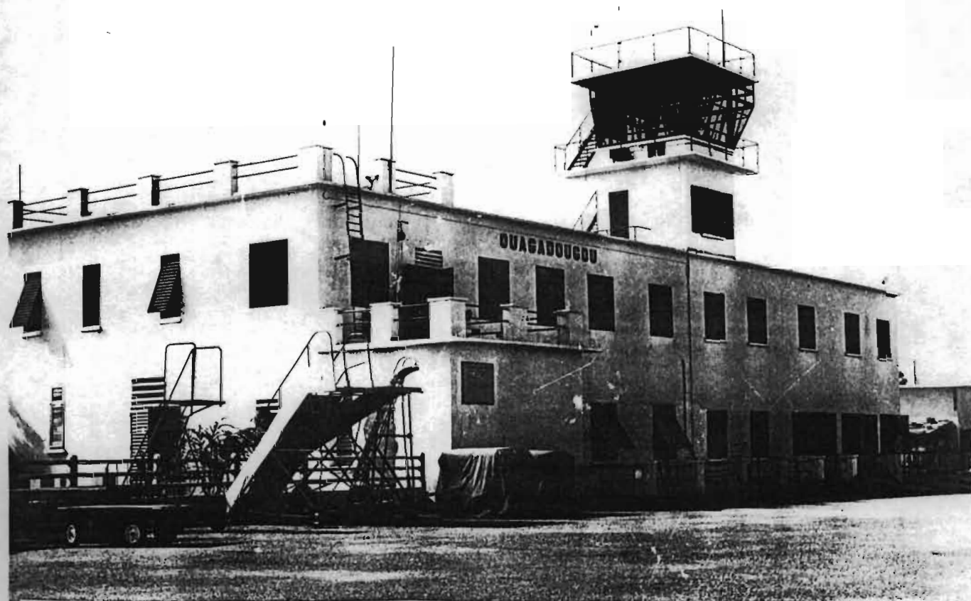
Aérogare de Ouagadougou, années 1950 ( photo ANSOM - France)
