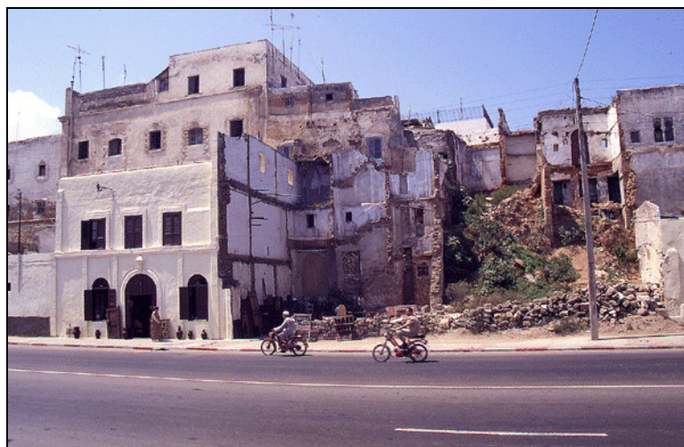
Des constructions en ruine
