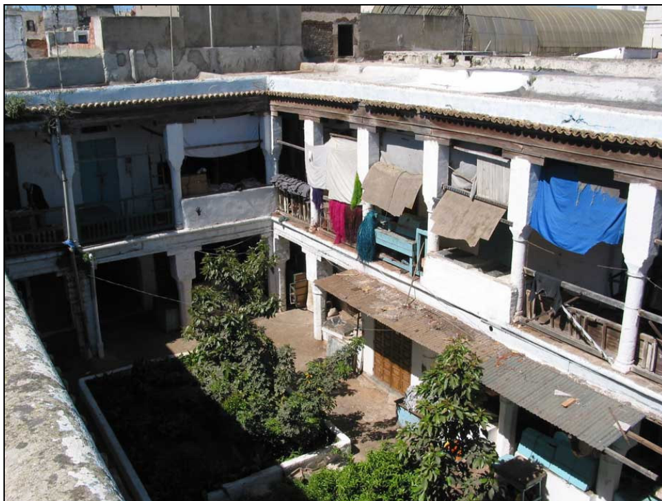
Fondouk squatté, un exemple de bâtiment à réutiliser
